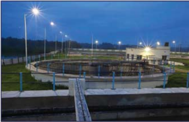
14 MLD STP Plant, Kolkata
